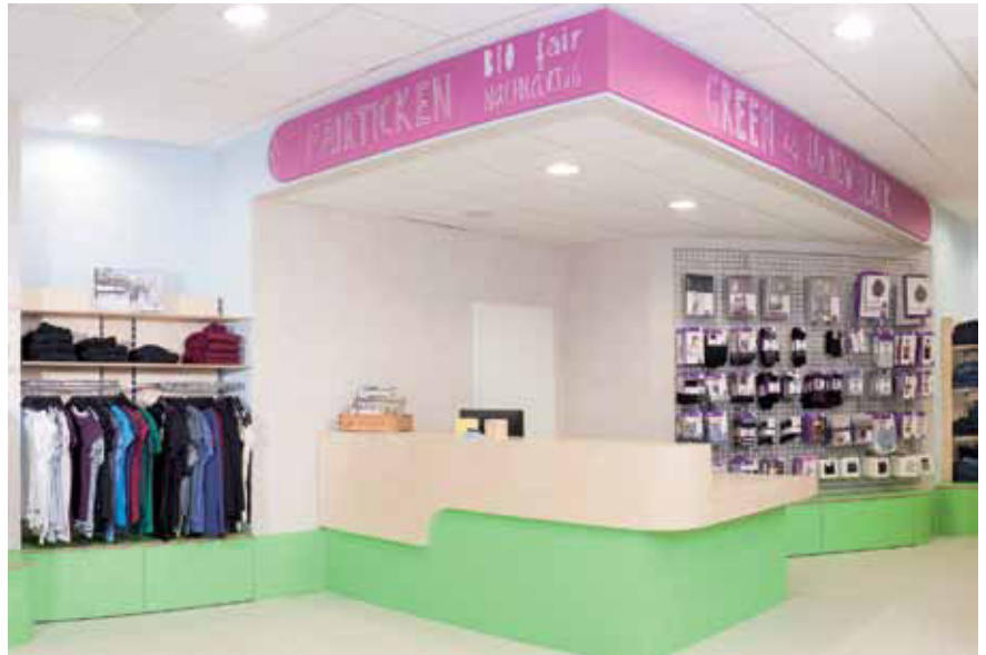
Eine grüne Bordüre aus HPL-Platten, die für den Sockelbereich besonders robust gestaltetet wurden, zieht sich durch den ganzen Laden.
